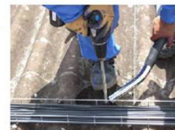
5 Percement en rotation lente, avec humidification et strict aspiration à la source. Aspirer également sous la toiture.
