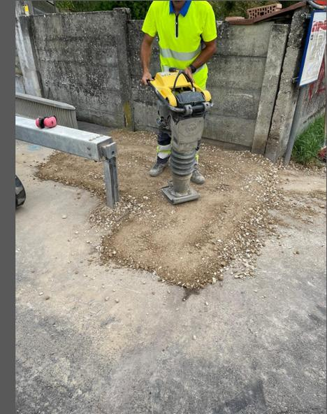
15h40. L'entreprise de maçonnerie a comblé la fouille. Elle posera du bitume dans la foulée.
