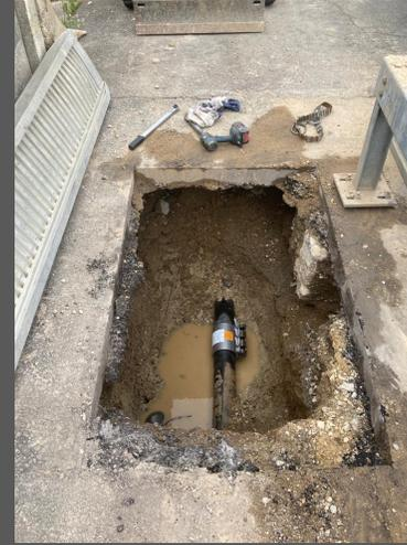
13h30. L'appareilleur a réparé la conduite. Remise en eau par nos surveillants de réseau
